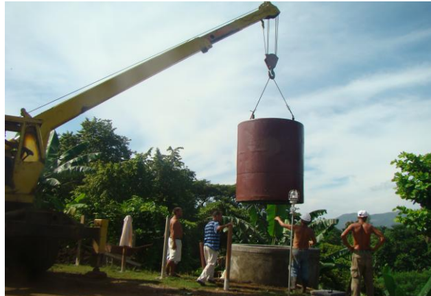
Figura 3: Apoyo de los comunitarios y del MICONS a la construcción del biodigestor
