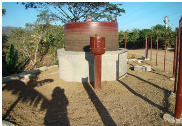
Figura 4: Biodigestor de cúpula fija finalizado
