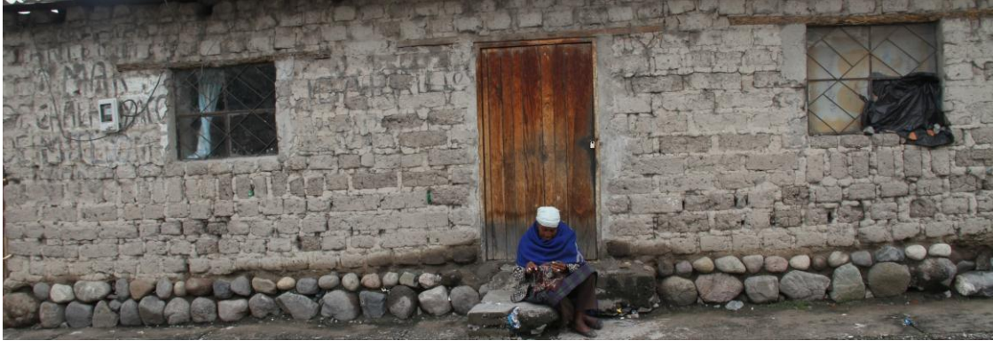
Figura 6: Señora cosiendo en la puerta de su casa de adobe con cimientos de piedra
