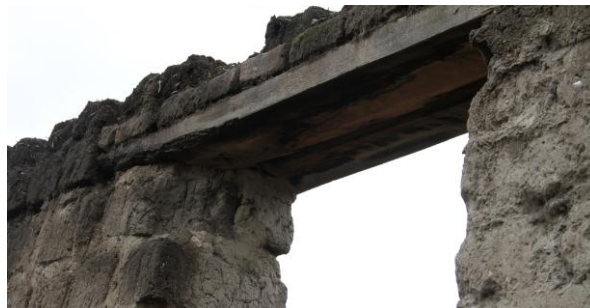
Figura 10: Dintel de madera encima del vano
