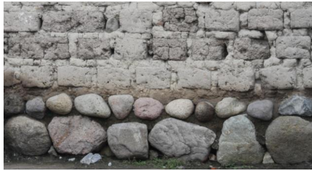
Figura 9: Cimientos de piedra y paredes de adobe
